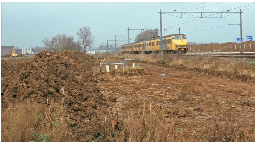
Figuur 2.9. Project Zv2. Zone op Zuiderveld-west waar de bovengrond strooksgewijs verwijderd is voor munitiedetectie ('verscheer').
