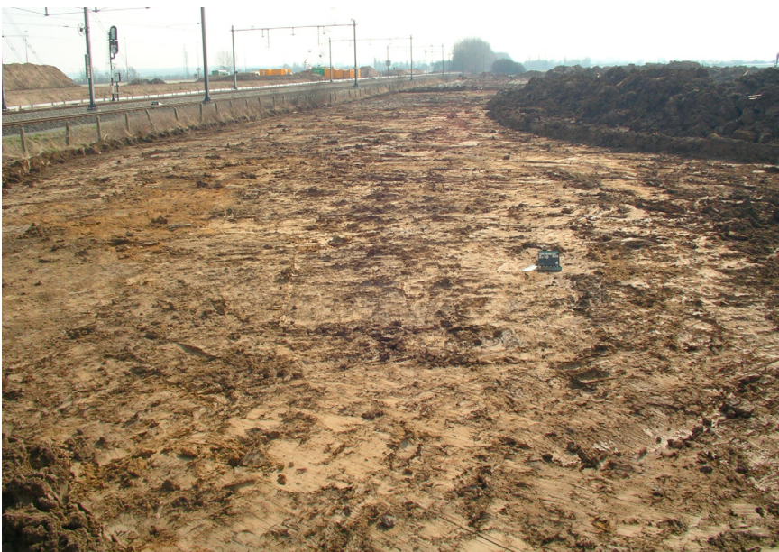
Figuur 2.17. Project Zv10. Put 1, gezien naar het zuiden.
