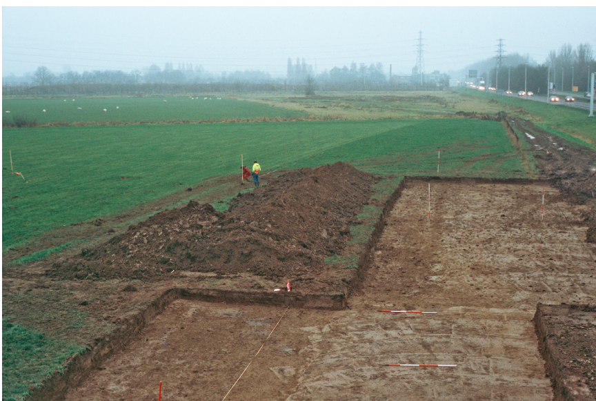
24 Figuur 2.14. Project Zv6. Overzicht, gezien naar het zuiden. BAMN
