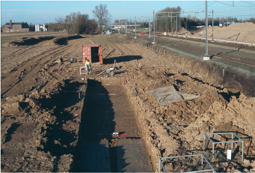
Figuur 2.15. Project Zv7. Overzicht put 1, gezien naar het zuiden.
