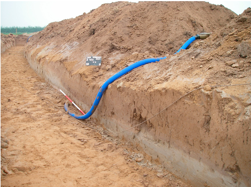
Figuur 2.21. Project Zv11. Leidingsleuf put 18, gezien naar het westen.
